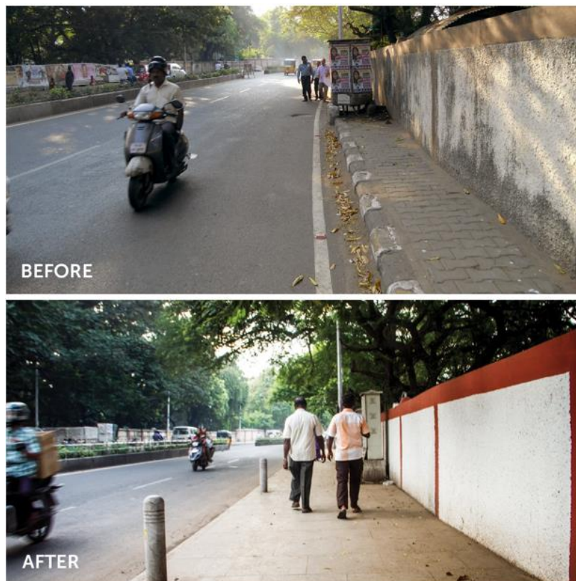
Εικόνα 9: Διαπλάτυνση πεζοδρομίου πριν και μετά
